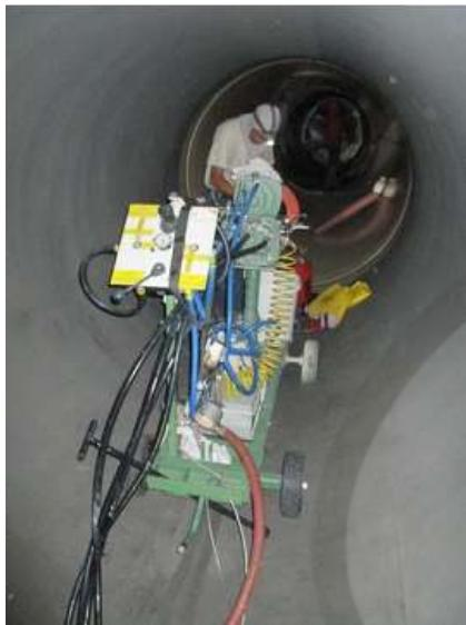
Este difícil proceso de pintura/recubrimiento interno de tuberías, se ha hecho más fácil (traducido en trabajo seguro), más rápido y más económico, gracias a su sistema de operación, donde el equipo alimentado con aire, se conduce a través de la tubería, mientras los atomizadores giratorios aplican el recubrimiento en
