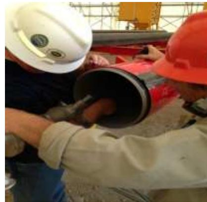
A medida que la unidad autopropulsada viaja a través de la tubería, un cabezal giratorio con tres o dos boquillas tipo Venturi, disparan abrasivo a la superficie interna del tubo.
